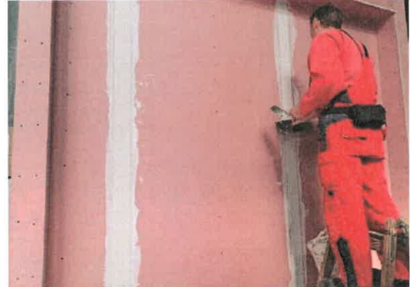
Bild A4.8 Fertigstellung der 2. Bekleidungs- / Beplankungslage der feuerzugewandten Seite.
