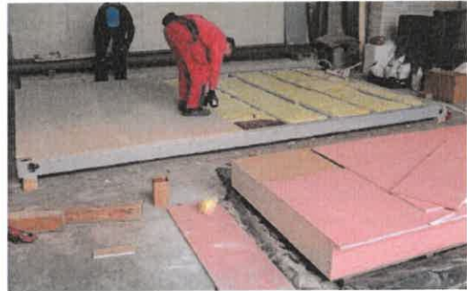
Bild A4.10 Ansicht der Bekleidung / Beplankung der feuerabgewandten Seite des Bodenmoduls.
