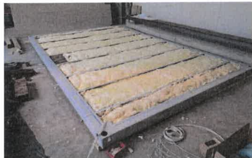
Bild A4.9 Ansicht der Gefachdämmung des Bodenmoduls.
